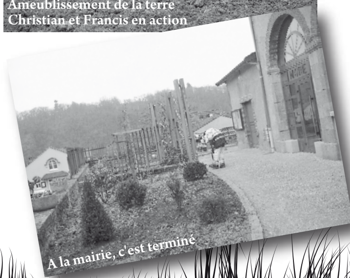
Mise en place des arbustes sur le parvis
